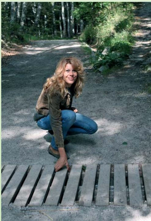
Водостоците са ремонтирани и изчистени след априлската акция, но преди зимата ще бъдат отново проверени
